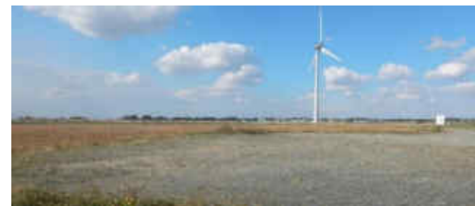
Photo 149 : Exemple d'aire de grutage depuis le pied d'une éolienne
