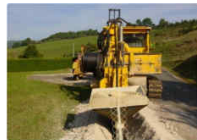
Photo 152 : La pose d'un câble souterrain depuis le poste de livraison jusqu'au réseau électrique public
