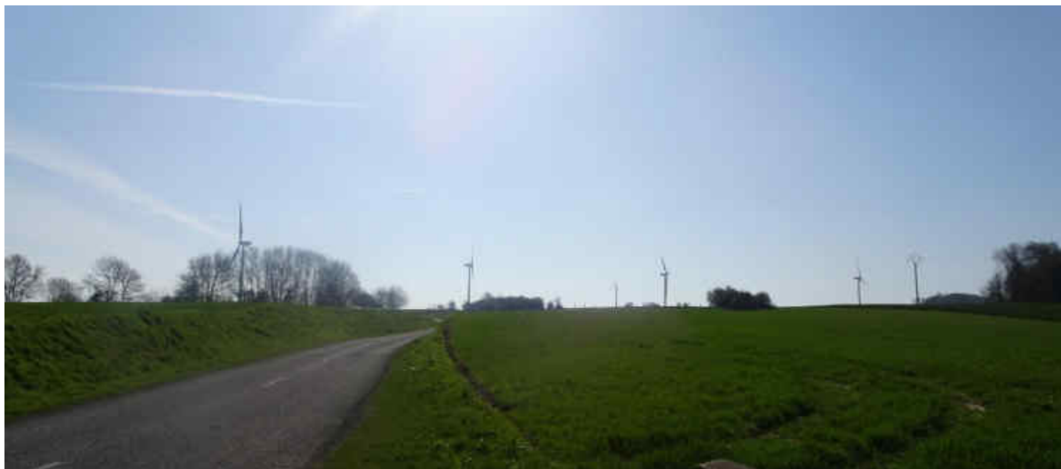
Photo 101 : Parc éolien des Tambours
