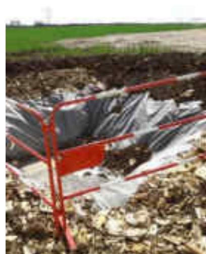
Coulage béton dans une zone aménagée. @Écosphère
