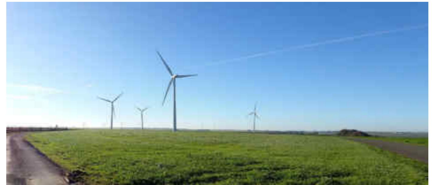
Photo 140 : Parc éolien du Chat Huant
