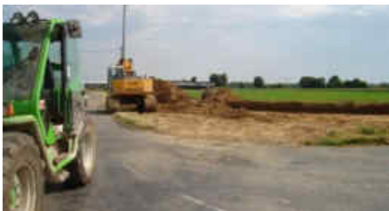
Photo 157 : les travaux de rectification d'un virage
