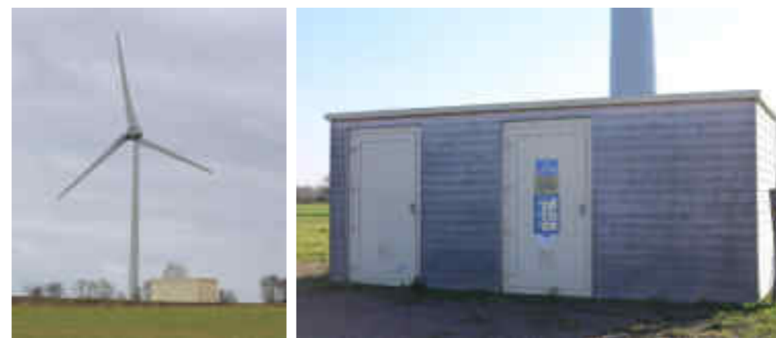
Photo 151 : Exemples de poste de livraison électrique
