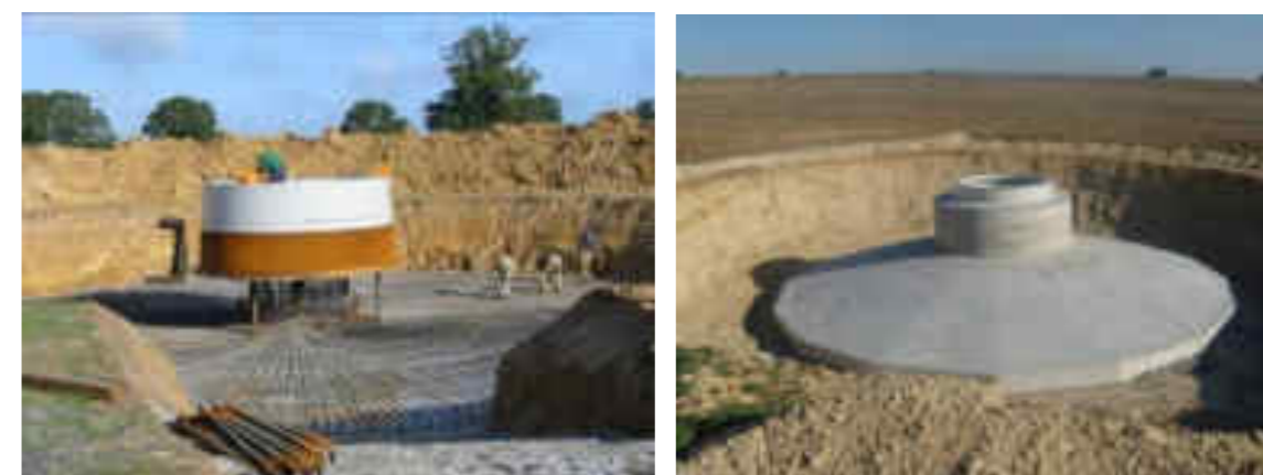
Photo 148 : Le coulage d'une fondation d'éolienne
