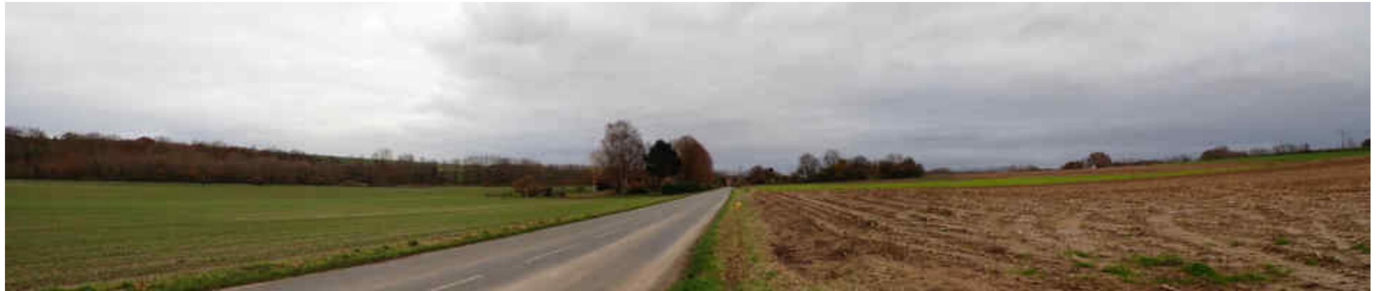
Photo 84 : Le VIP apparaît tronqué et filtré par la végétation qui émane du village d'Aubrometz depuis la RD 340
