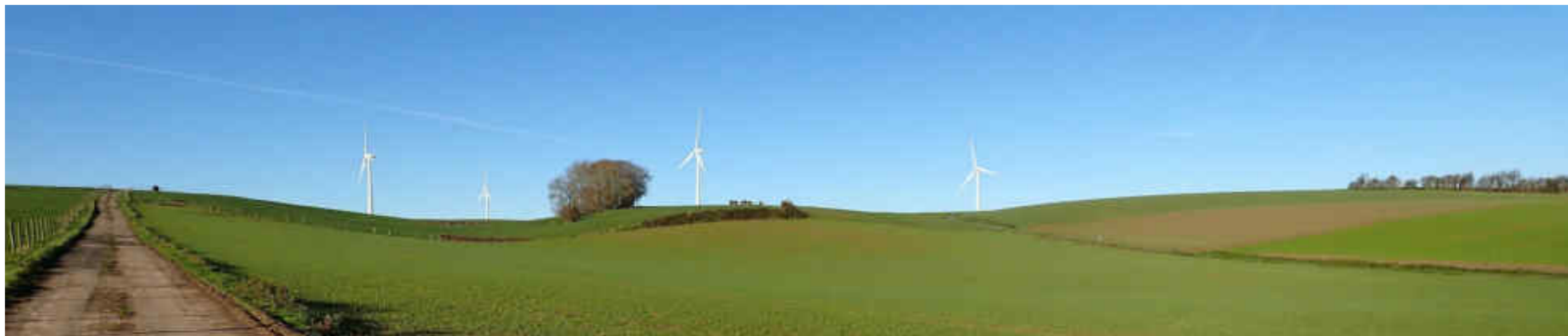
Photo 100 : Parc éolien du Chat Huant
